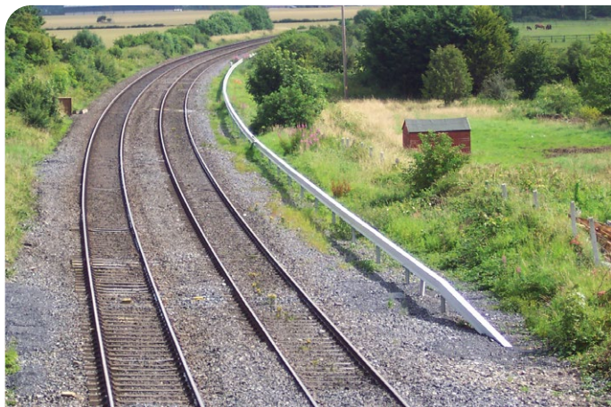
VARIO TOP Gr. 2 entlang der Gleisstrecke
