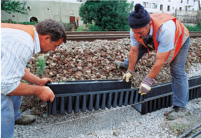
Verlegen der Kanäle in der vorbereiteten Trasse
