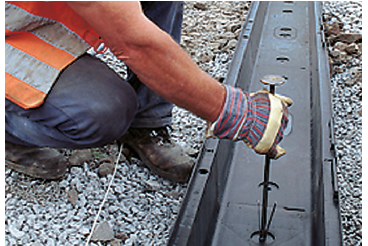
Fixieren des Kabelkanals mit speziellen Erdnägeln nach örtlichen Erfordernissen
