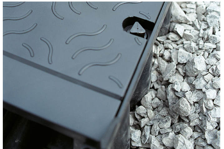
Verfüllung der Kabelkanäle
